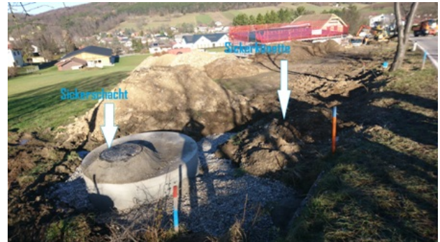
Sickerbecken und -künette
